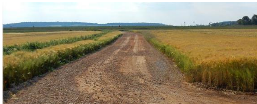
Figure 4 : Un exemple de voie d'accès à un parc éolien
